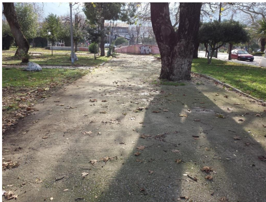
Φωτ. 5. Διαμορφώσεις με σκυρόδεμα
